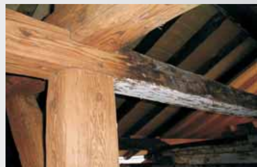
Dachgebälk.. Entfernung von mineralischen Anstrichen
