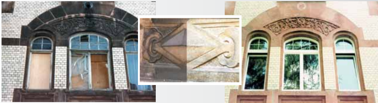
Natursteinreinigung mit dem SAPI „Vario“ Wirbelstrahl-Reinigungsverfahren
